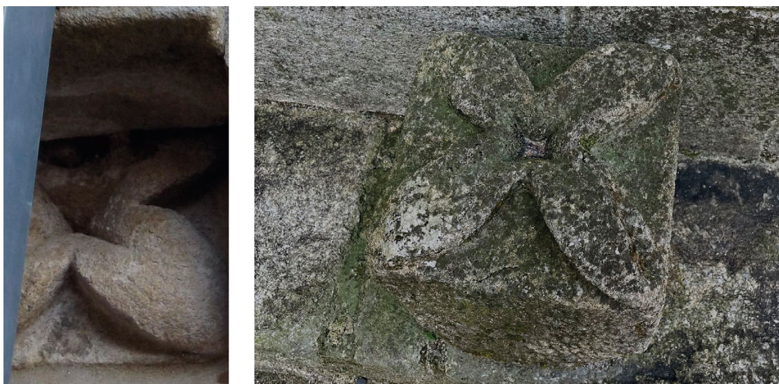
▪ Fig. 11. Restos escultóricos sobre el muro sur del presbiterio (izquierda) y metopa descontextualizada frente a la Puerta de la Misericordia (derecha), Catedral de Ourense. 2021 (izquierda) y 2024 (derecha). Fotografías del autor.
