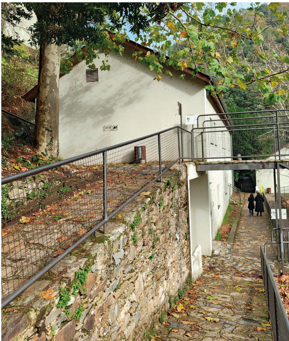
▪ Figura 6. Fotografía de las edificaciones de uso residencial en la actualidad. Fotografía de la autora.
