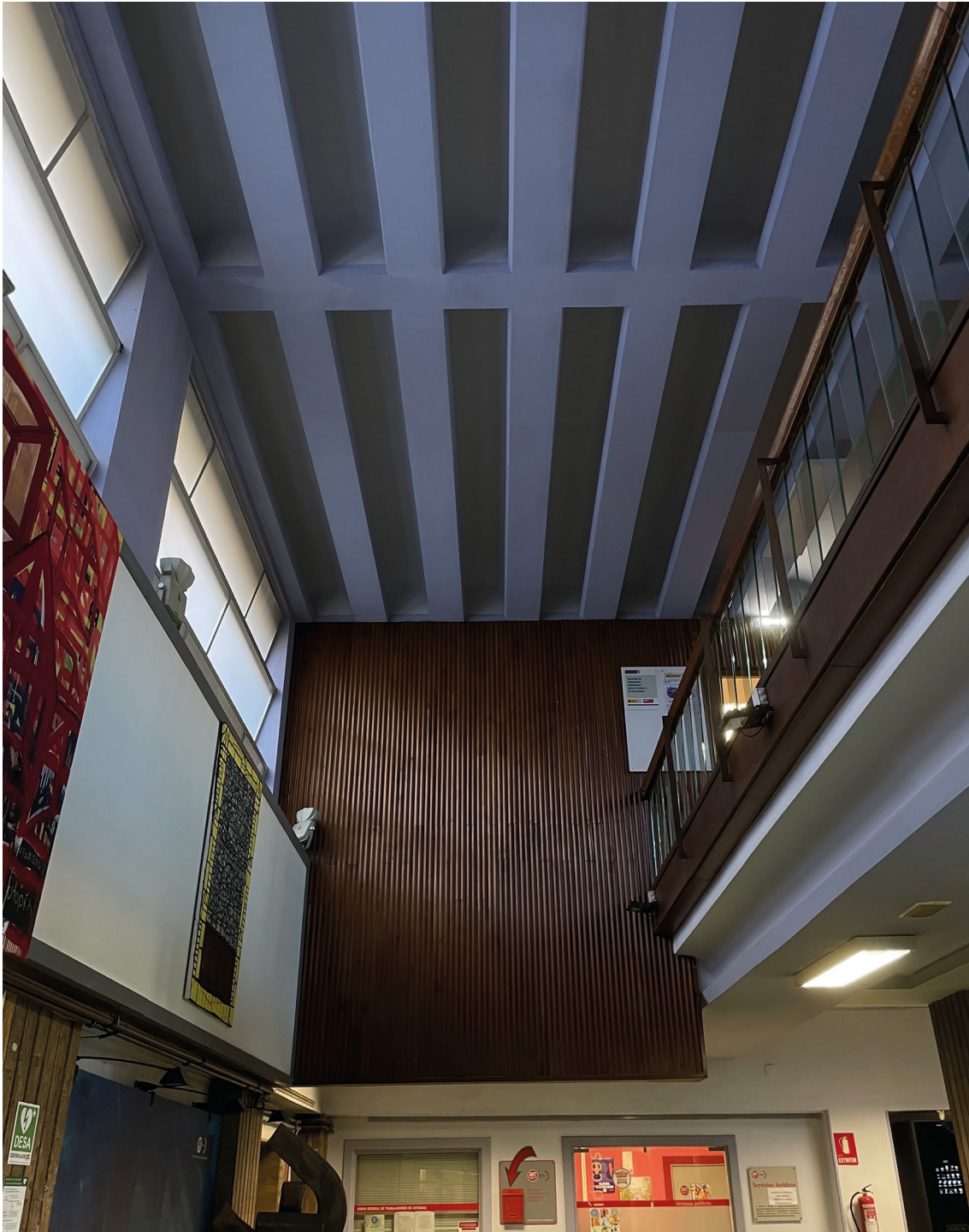
▪ Fig. 7. Federico Somolinos. Interior del hall de entrada de la Casa Sindical de Oviedo. Fotografía del autor.
