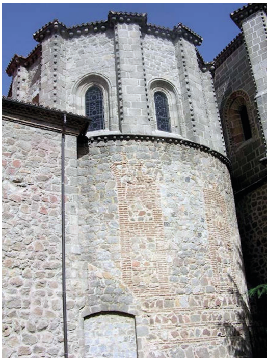
▪ Fig. 2. Ábside. Foto del autor.
