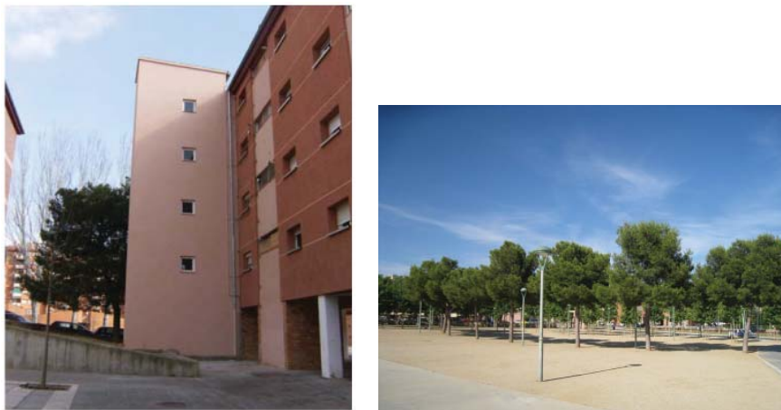
Figura 5. Instalación de ascensores en bloques del grupo Juan Carlos de La Mariola y vista general de la Plaza Mayor de Campclar
