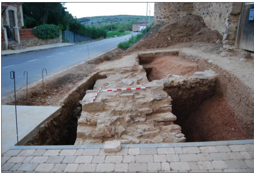
Foto 2. Antemuro de mampostería
