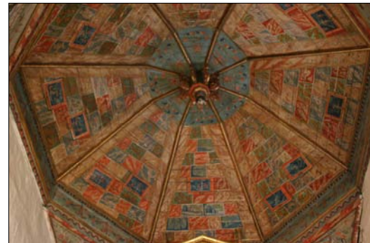
■ Fig 9. Armadura ochavada, policromada, del presbiterio de la iglesia de Pozos..
