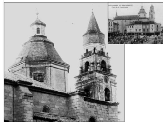
■ Lám. 5. Iglesia de Peñaranda de Bracamonte. Exterior antes del incendio. Reportaje gráfico conservado en la Casa Parroquial de Peñaranda. Primera década del siglo XX. Fuente: Tarjeta Postal. Imp. Miguel Coll. Depósito Legal S-35-1998.
