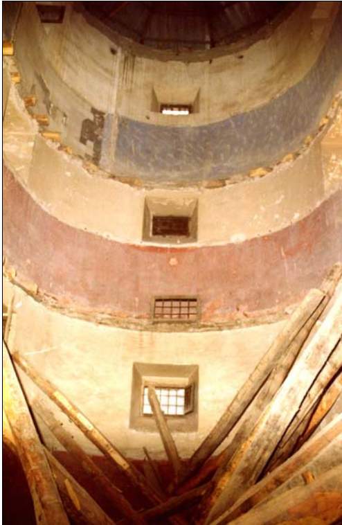
■ Lám. 6. Interior de uno de los cubos del castillo, completamente vaciado, antes de hacer las estructuras interiores para acondicionar el Archivo.
