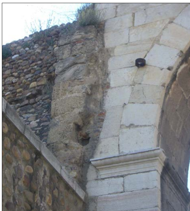
■ Lám. 8. Detalle del pilar de sillares antiguos adosado a la estructura de la puerta
