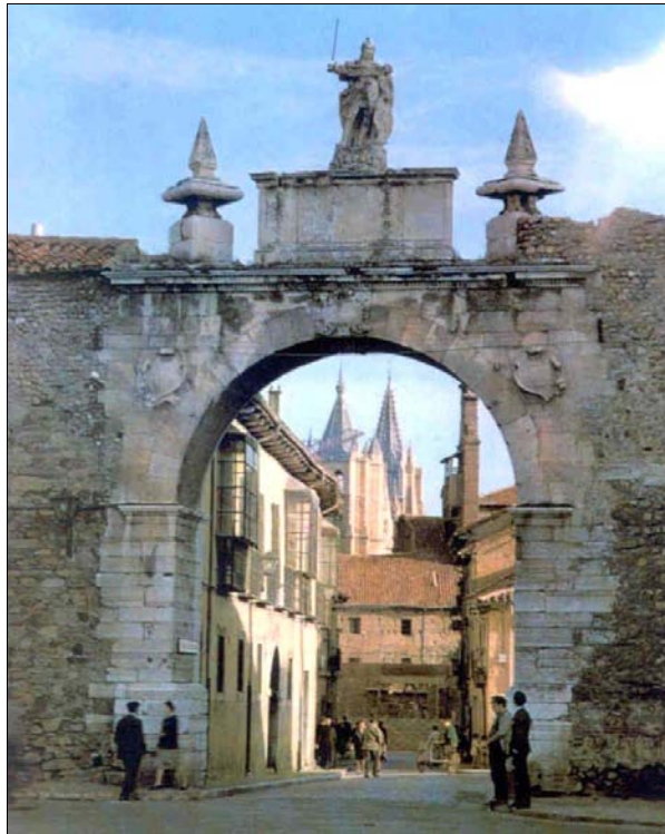
■ Lám. 1. Puerta Castillo antes de desmontar el remate
