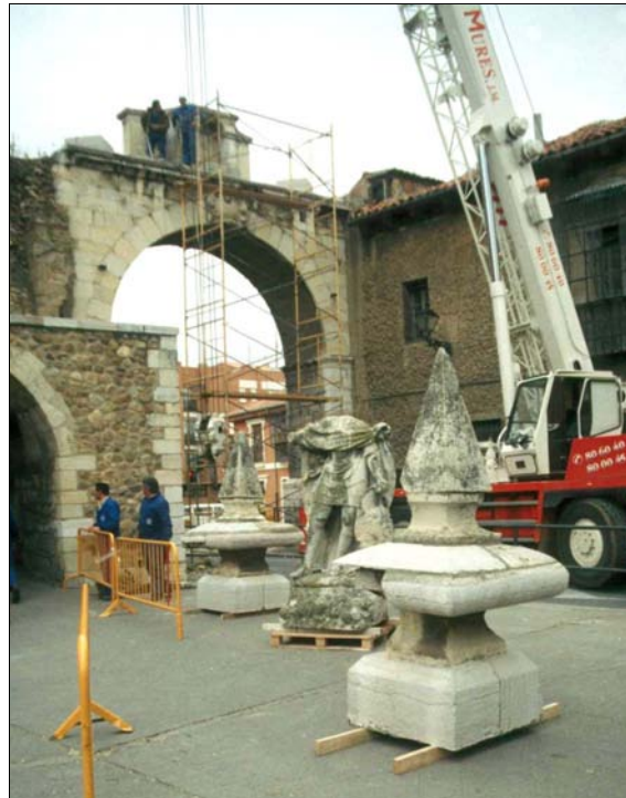
■ Lám. 9. Desmontaje de la escultura y los adornos de Puerta Castillo
