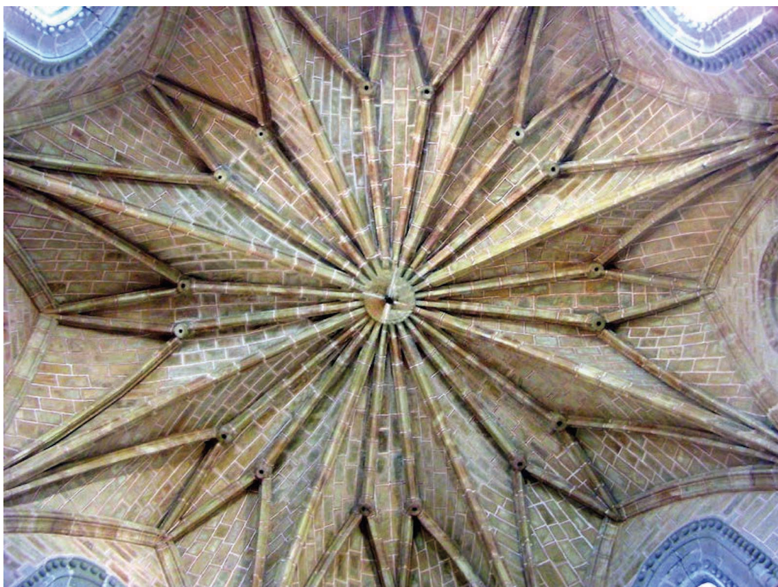
▪ Fig. 10. Capilla de san Antonio. Bóveda. Foto del autor.
