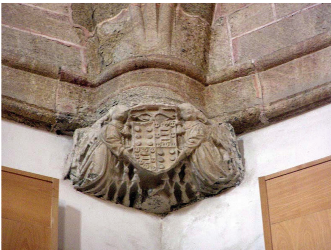
▪ Fig. 9. Capilla de san Antonio. Ménsula. Foto del autor.
