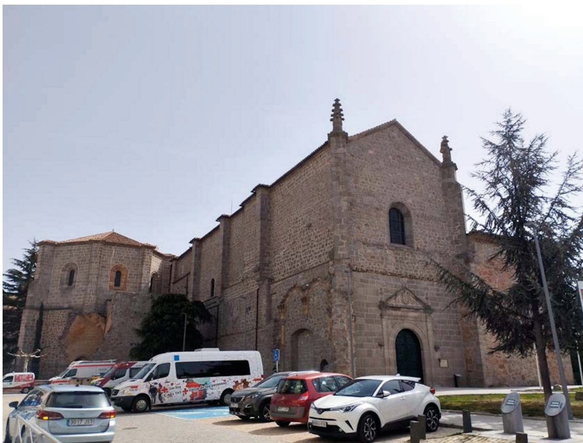
▪ Fig. 1. Vista del convento desde el noroeste. Foto del autor.
