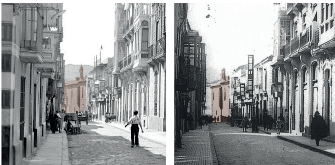
▪ Fig. 5. Calle San Torcuato y el Hospital de Sotelo al fondo de la calle. Se aprecia el antes y el después al derribo parcial del edificio (izquierda: IPCE, fototeca, LOTY-02401; derecha: AJGS).
