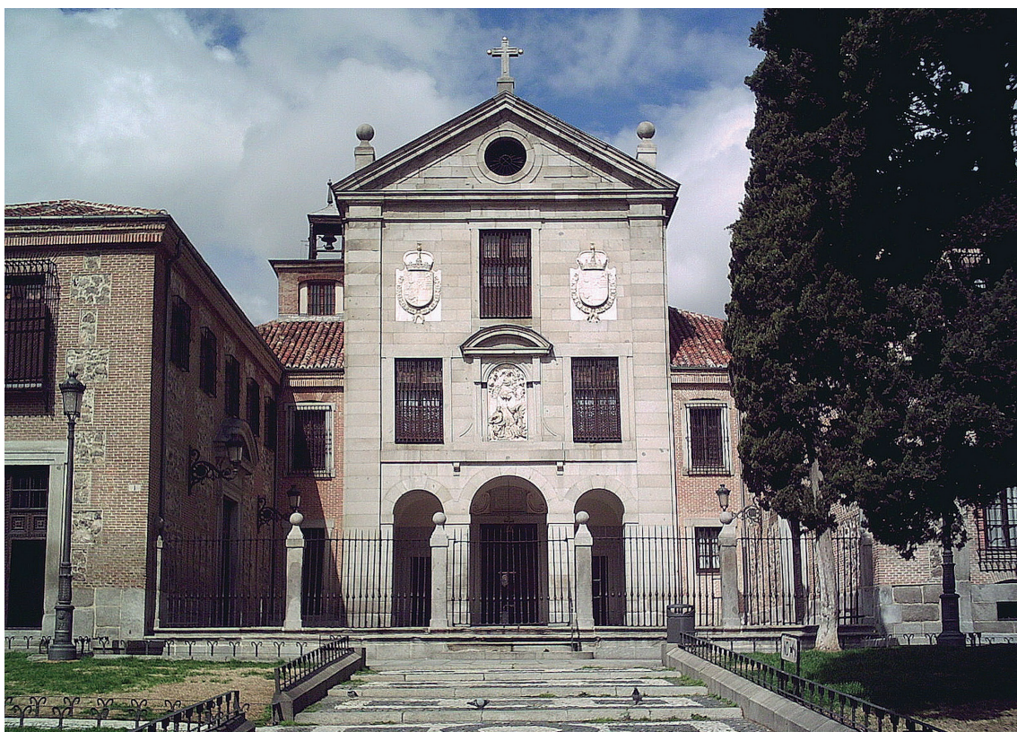
▪ Fig. 6. Iglesia del Real Monasterio de la Encarnación, Madrid. Construida entre 1611 y 1616. Fotografía Luis García, 2013.
