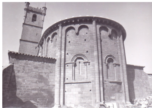
▪ Fig. 7. Iglesia de San Martín, Uncastillo, vista del ábside en abril de 1972, tras concluir su restauración. Fuente: Archivo constructor Jesús Tricás.
