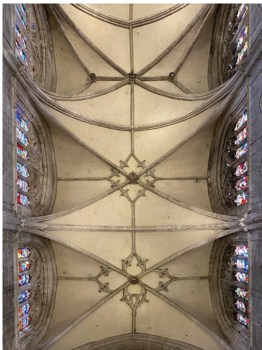
▪ Fig. 3. Bartolomé de Solórzano. Bóvedas de la nave central de la catedral de Oviedo. 1490. Foto de la autora.
